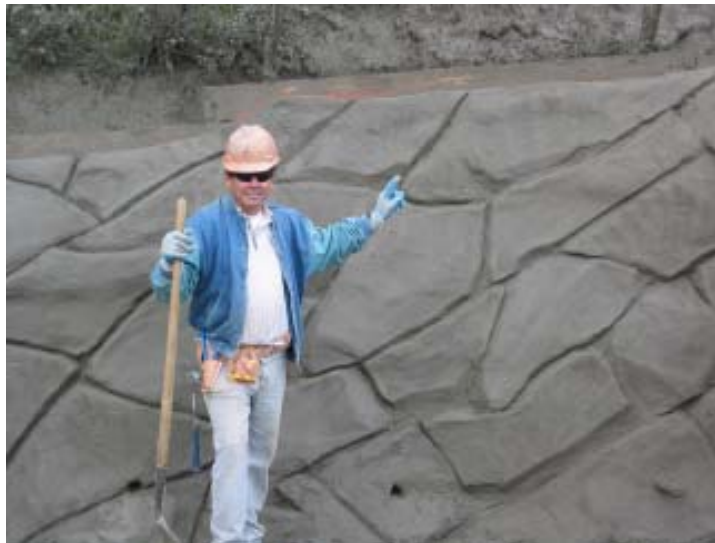
Trainee shows what he learned building an architectural shotcrete retaining wall. (Estudiante muestra la pared retenedora que aprendió a construir en una clase de concreto especializado.)
